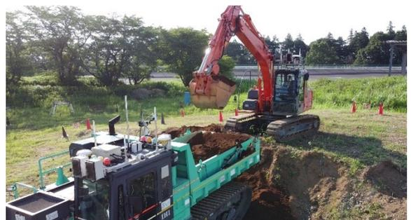
図1 自動建機による掘削/積込み
